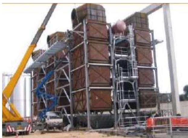
РИСУНОК 3. Котел-утилизатор
