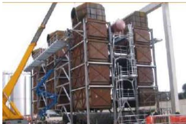
РИСУНОК 3. Котел-утилизатор
