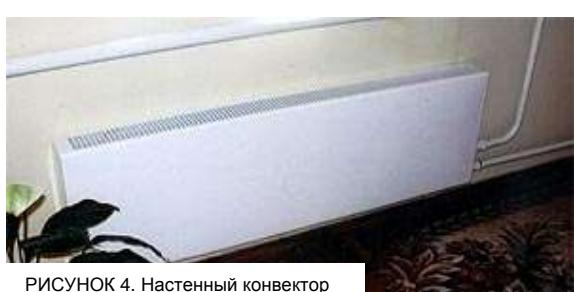
РИСУНОК 4. Настенный конвектор
