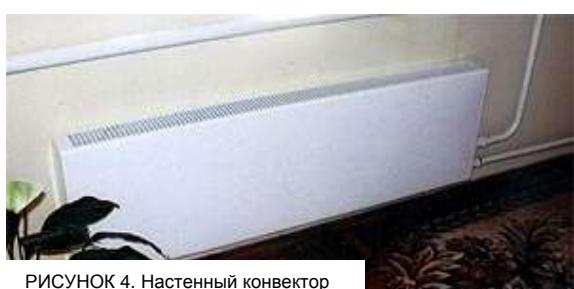
РИСУНОК 4. Настенный конвектор
