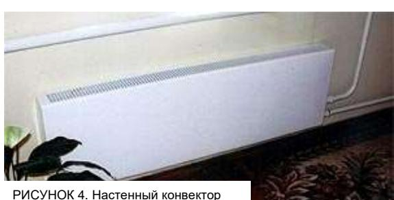
РИСУНОК 4. Настенный конвектор
