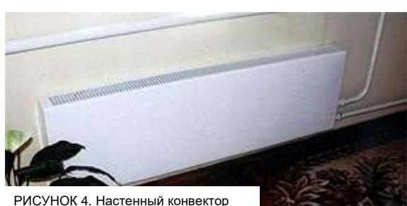
РИСУНОК 4. Настенный конвектор
